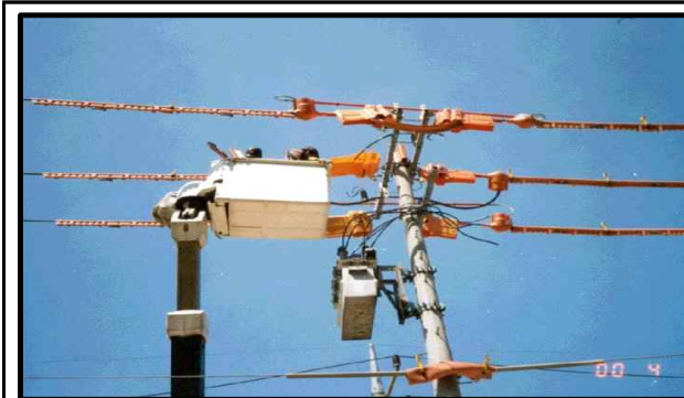
작업구간 인접충전선로에 절연방호구 설치 ○
