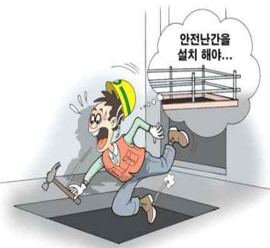
추락 위험구역에 안전난간 설치
