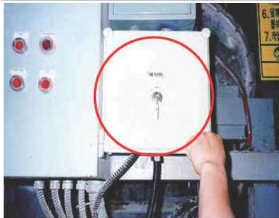
키타입 기동스위치 설치
