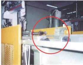
안전문 연동장치 설치
