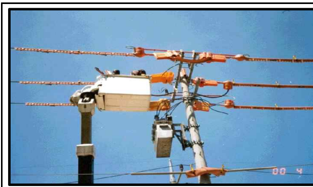
작업구간 인접충전선로에 절연방호구 설치 ○
