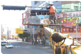
신호등 설치·해체 작업
