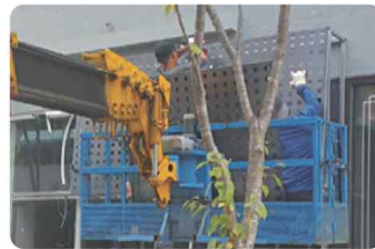
간판 설치·해체 작업
