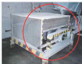
테일폴리* 방호울 설치 (컨베이어 끝단을 지지하는 폴리)
