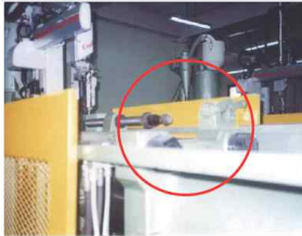
안전문 연동장치 설치
