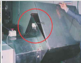
덮개 및 연동장치 설치
