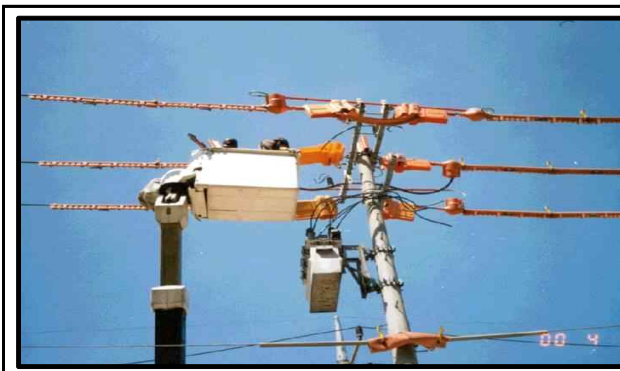
작업구간 인접충전선로에 절연방호구 설치 ○
