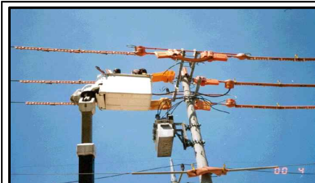
작업구간 인접충전선로에 절연방호구 설치 ○
