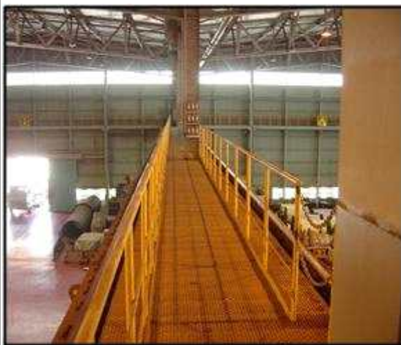
안전난간 설치
